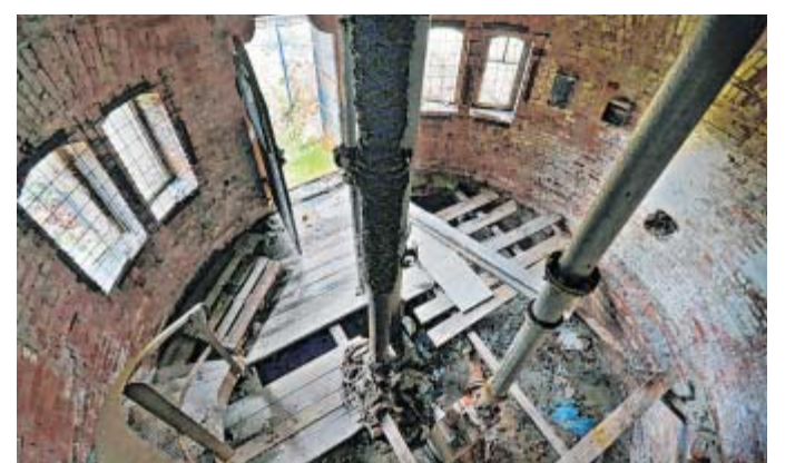
Schwindelerregend: Der Blick von oben auf den heutigen Eingang und die Stahlträger, die die schwere Wasserkugel halten.
