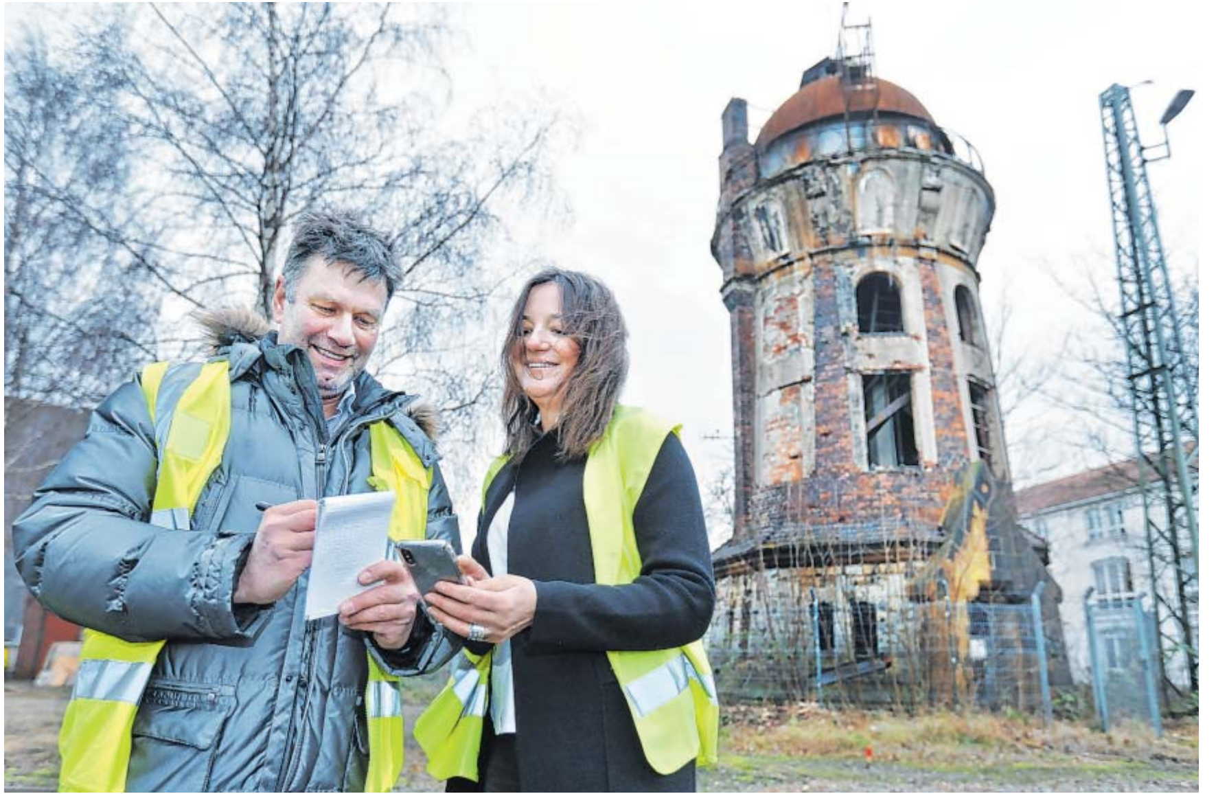
Wasserturm gekauft: Anja Padberg und Thorsten Hojas von der Firma „MacanT“ wollen aus dem Jugendstil-Denkmal ein neues Wahrzeichen machen.
